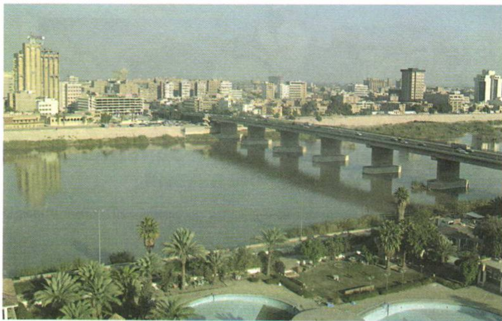
Рис. 427. Мост через Евфрат в Багдаде (Ирак)
